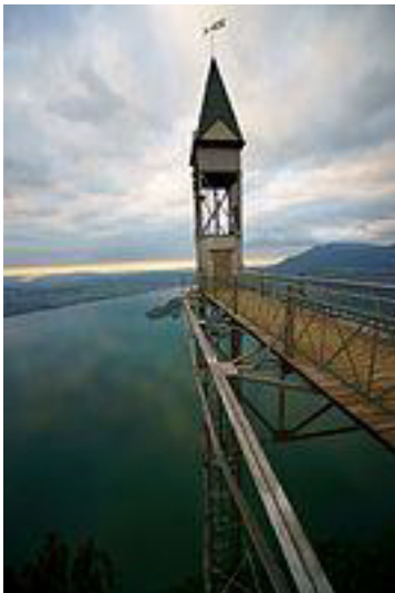
Hammetschwandlift über dem Vierwaldstättersee (Luzern).
